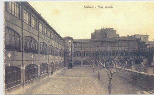
Vue des bâtiments C et D.
