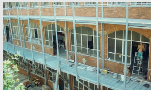
Vue des bâtiments C et D.
